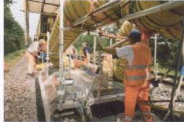
Foto: Bayer MaterialScience Weniger Lärm durch Schaum im Gleisbett
